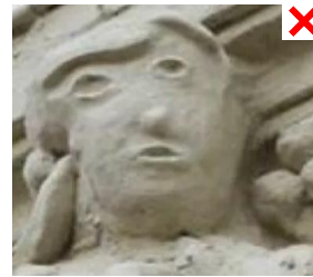
⊘ потеря пластики декора из-за многослойных окрашиваний и (или) окрашиваний без восполнения дефектов элементов декора
