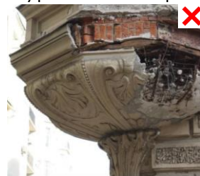
⊘ обнажение крепежных элементов
