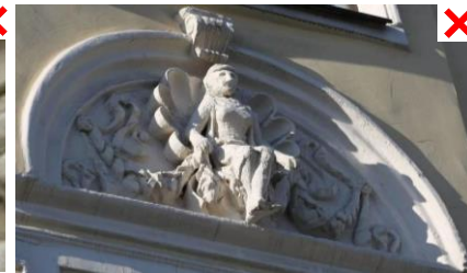
⊘ потеря пластики декора из-за многослойных окрашиваний и (или) окрашиваний без восполнения дефектов элементов декора
