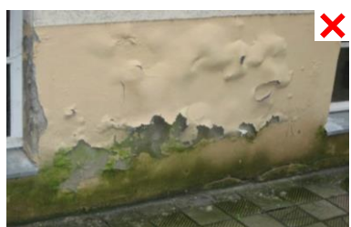
⊘ иные разрушения красочного слоя
