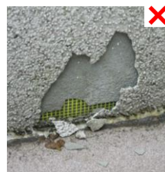
⊘ иные разрушения красочного слоя
