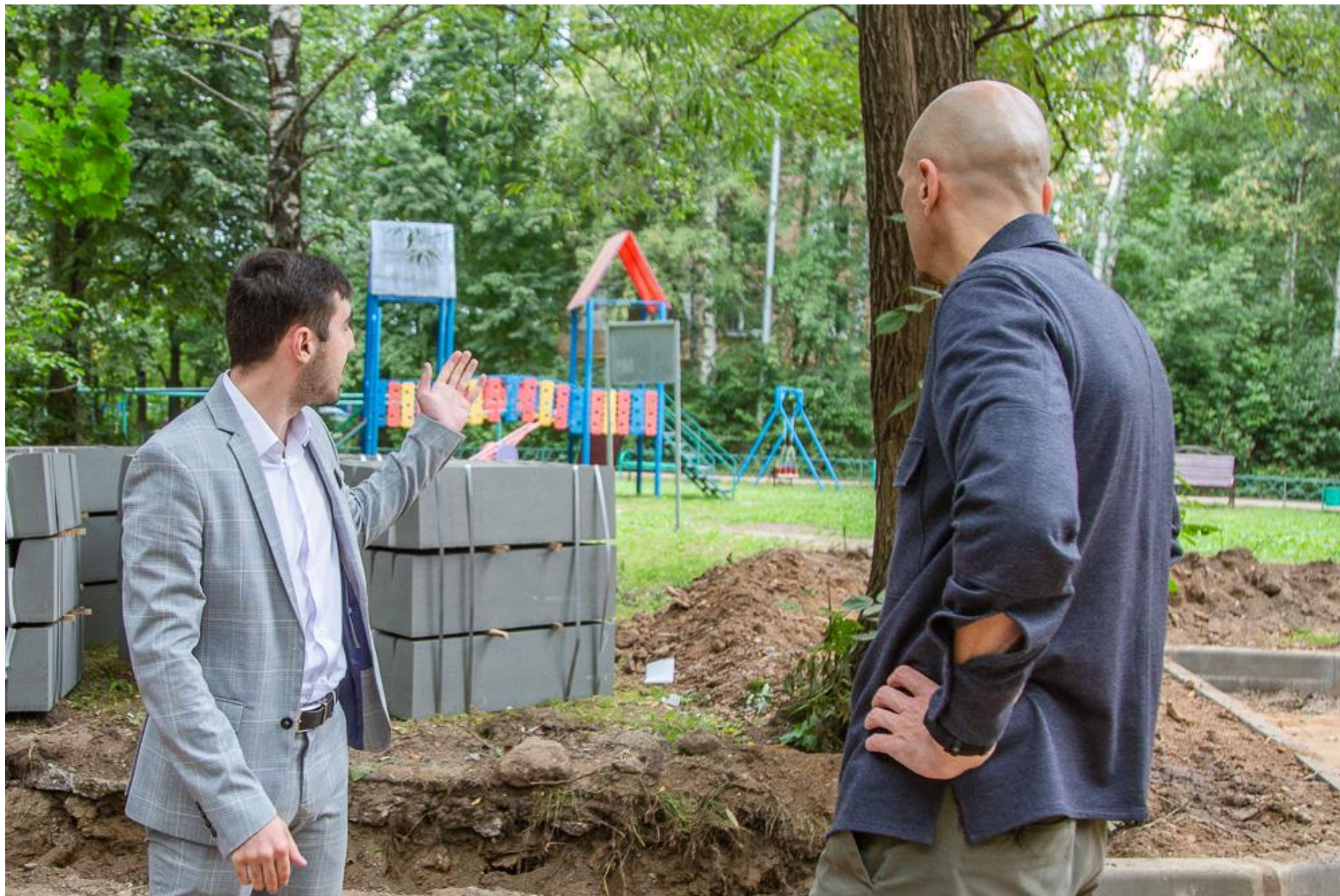
Фото №2 (ход монтажных работ)
