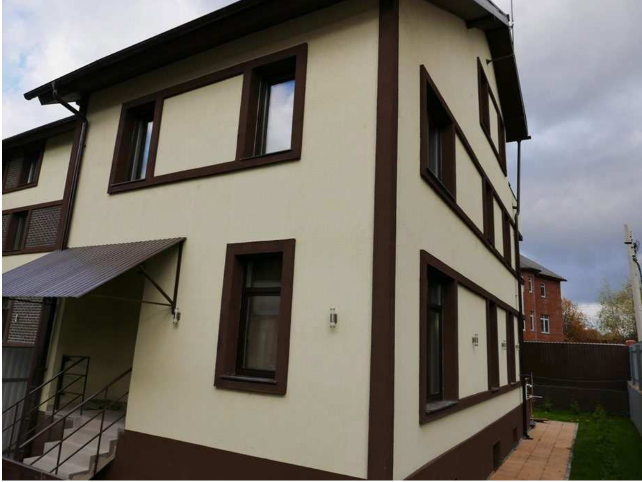
Рисунок 4.1 Фотофиксация существующего состояния территории
