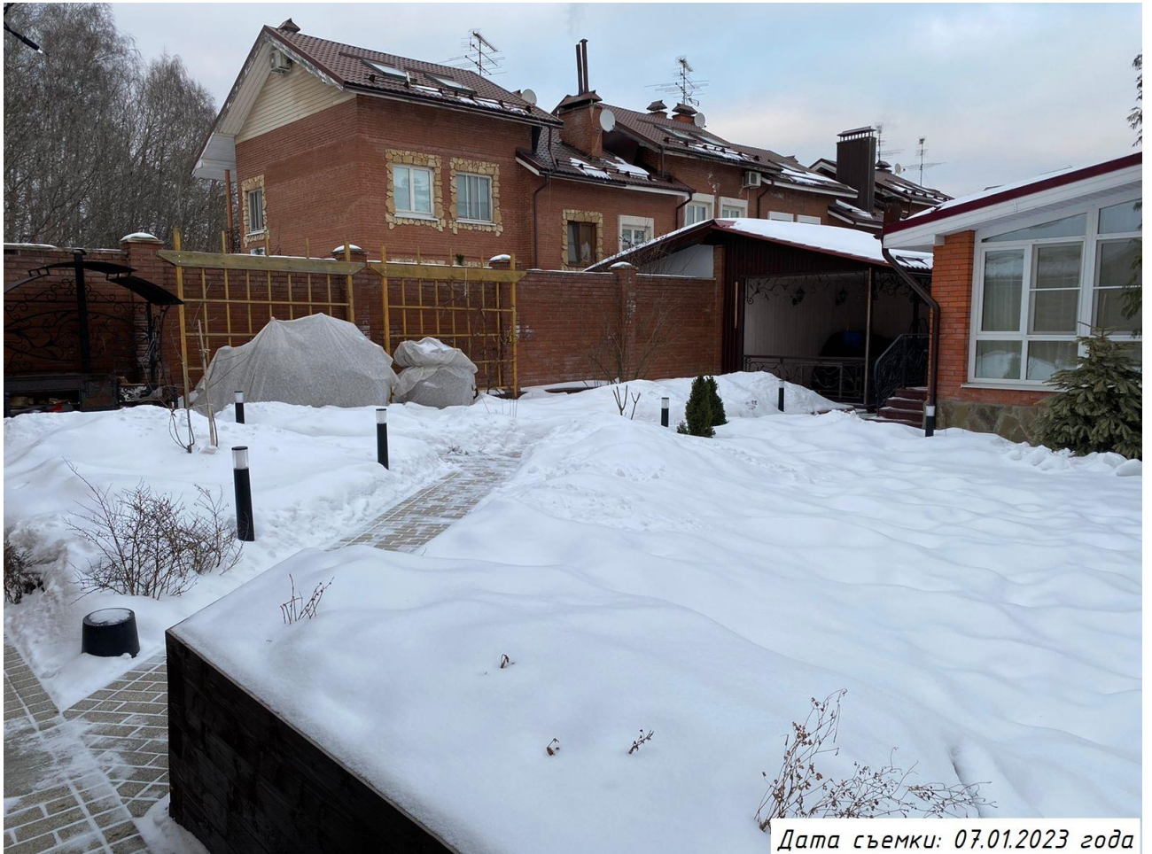
Рисунок 4 – Фотофиксация существующего состояния территории
