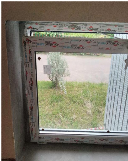
установка откосов оконных блоков
