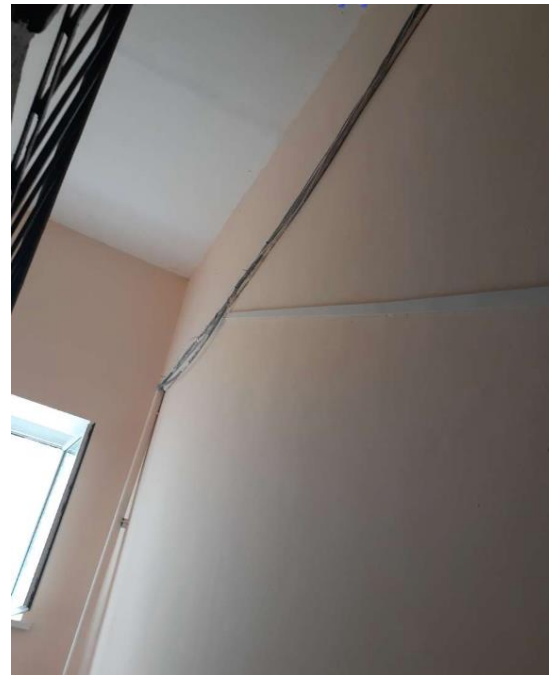
затягивание проводов в электрические короба
