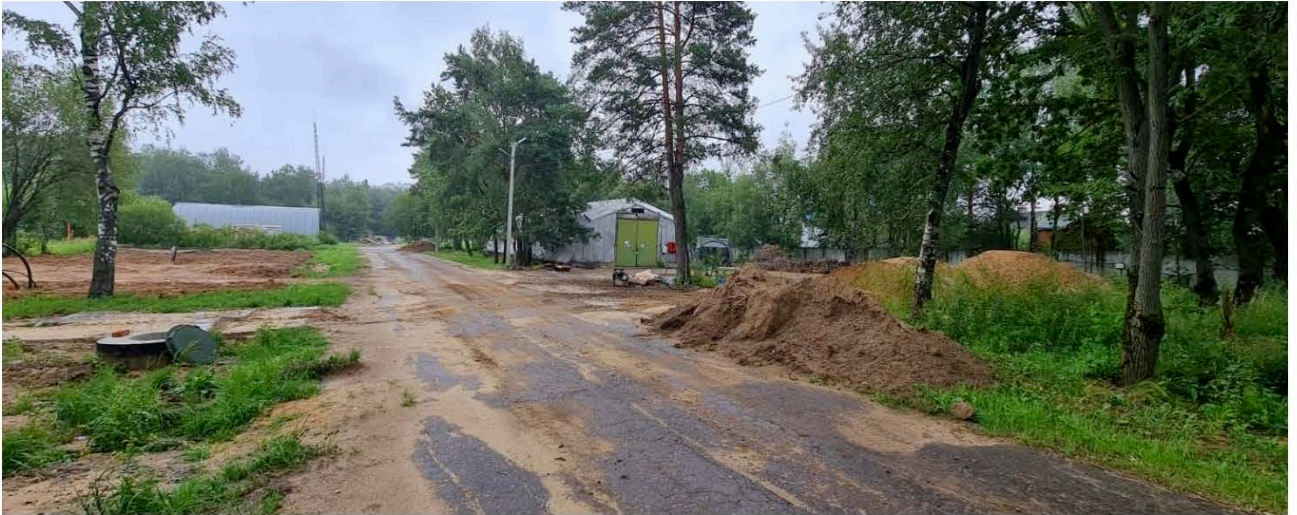
Рисунок 4 – Фотофиксация существующего состояния территории
