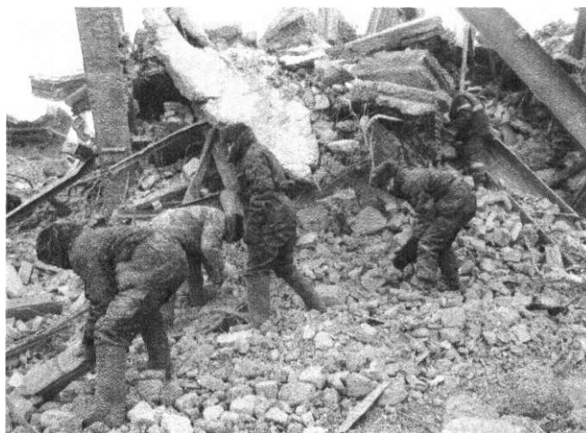
Рис. 10. Спасательные работы после землетрясения
