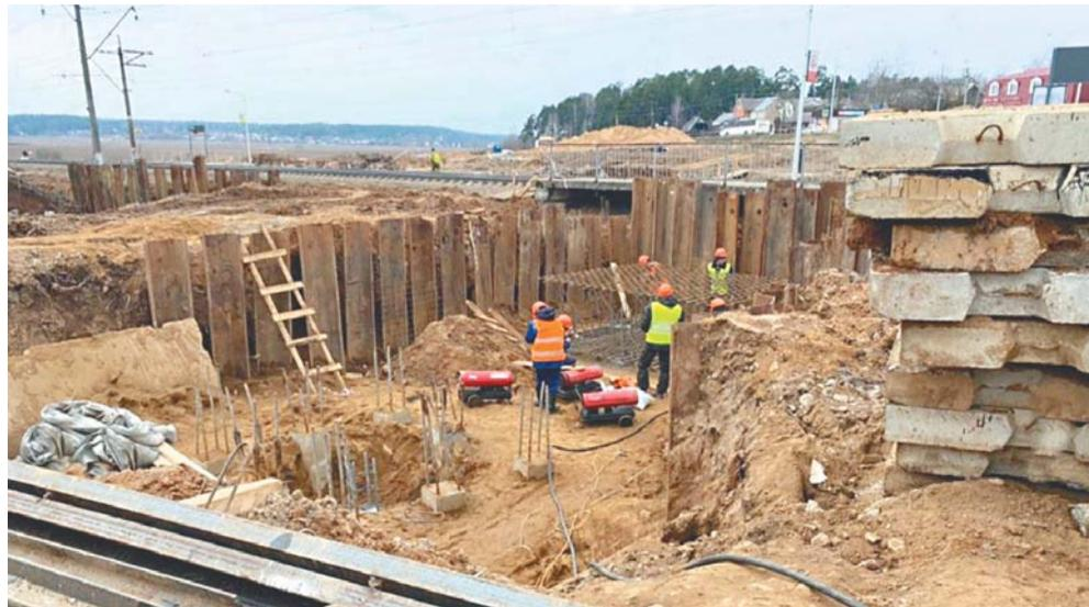
**Н**о просто «забросить» стройку нельзя. Нужно исключить возможные подвижки и просадку грунта, его размывание подземными водами. Рядом находится железнодорожное полотно, а значит, необходимо принять меры, чтобы не допустить его разрушения и аварийной ситуации.
