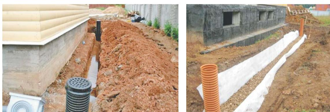
стично осушить местность, но еще и спасти «дорожную одежду» в зимнее время. Замерзая, вода вскрывает асфальт, силы пучения сырых грунтов поднимают вверх даже тяжелые железобетонные плиты...
