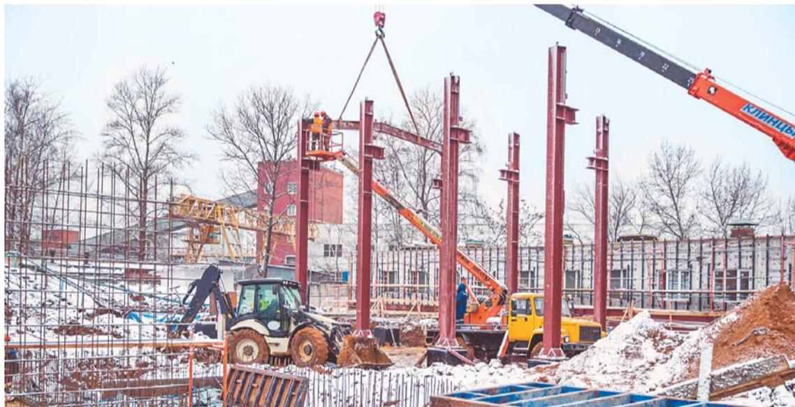
век и четыре единицы техники. Уже проведены работы по демонтажу резервуара чистой воды, подготовлен котлован и залиты фундаменты под новый резервуар и здания фильтрации. Параллельно идет капитальный ремонт с полной заменой оборудования в здании второго подъема, которое обеспечивает давление в кранах жителей.
