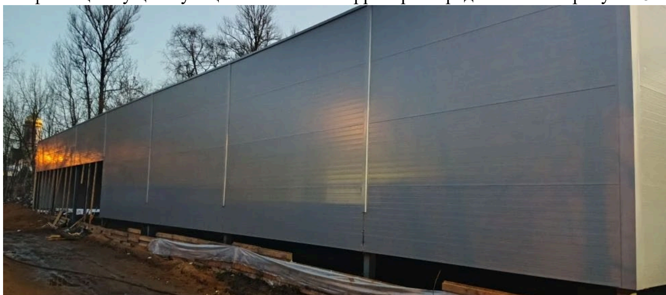
Рисунок 5 – Панорамная фотофиксация местности (дата съемки 18.03.2026г.)
