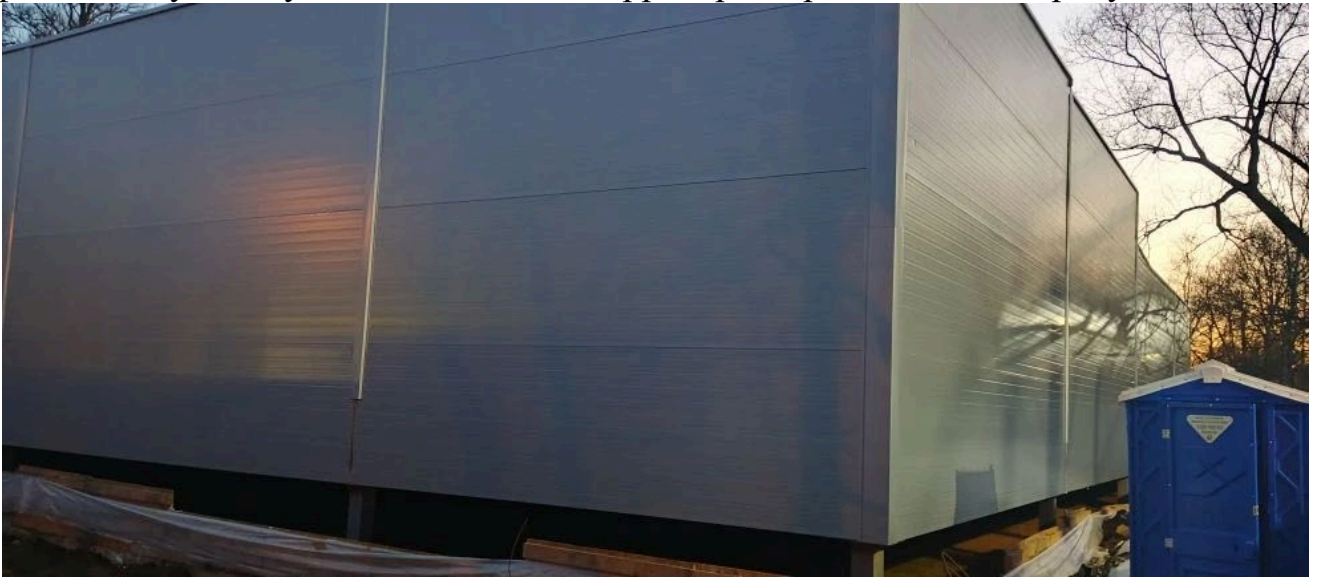
Рисунок 6 – Панорамная фотофиксация местности (дата съемки 18.03.2026г.)
