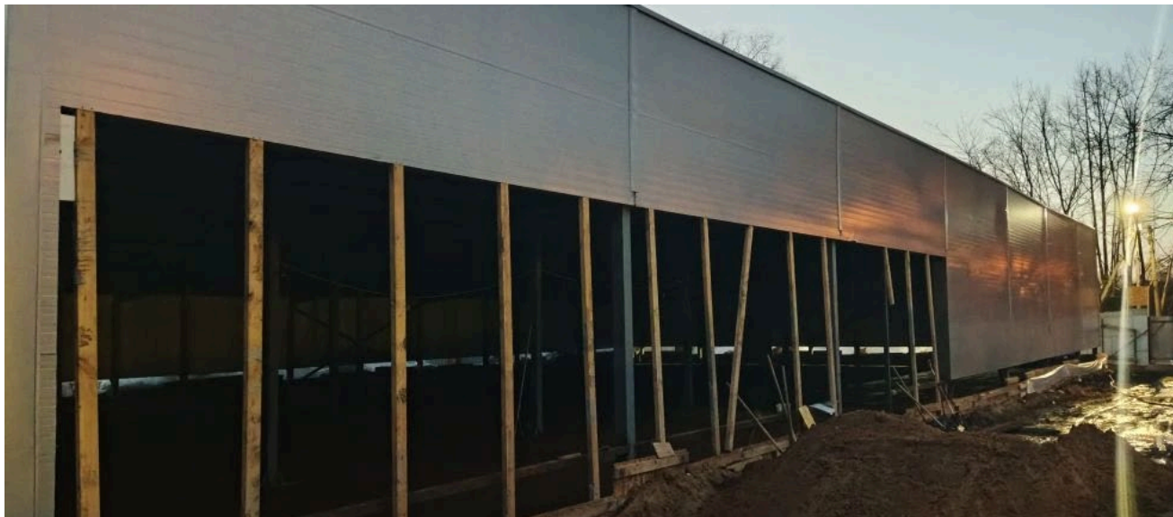
Рисунок 4 – Панорамная фотофиксация местности (дата съемки 18.03.2026г.)
