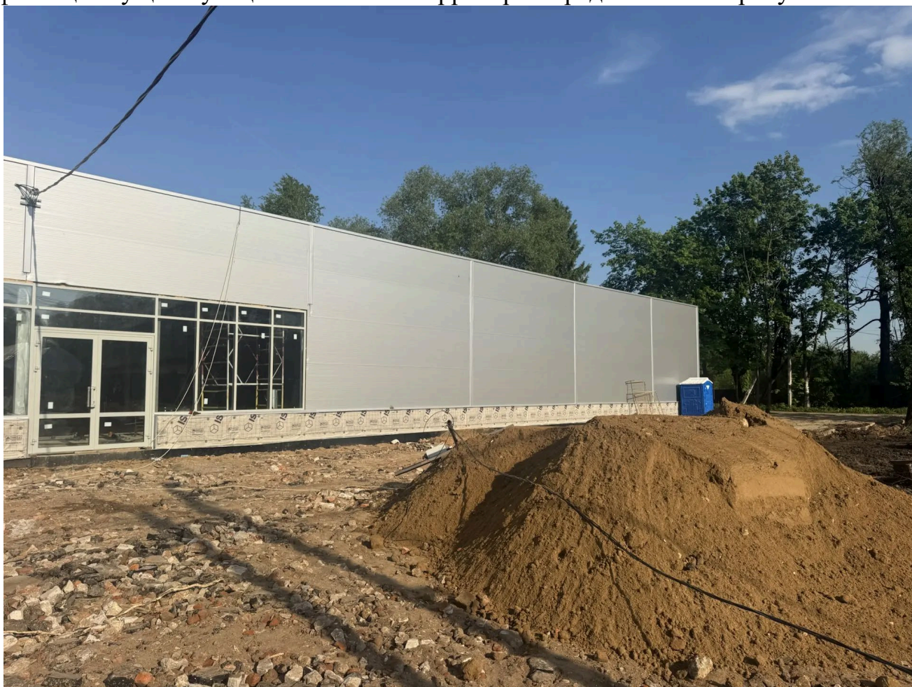
Рисунок 6 – Панорамная фотофиксация местности (дата съемки 21.05.2026г.)
