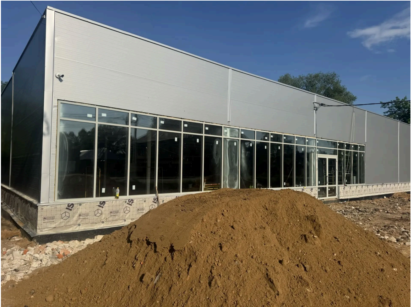
Рисунок 4 – Панорамная фотофиксация местности (дата съемки 21.05.2026г.)
