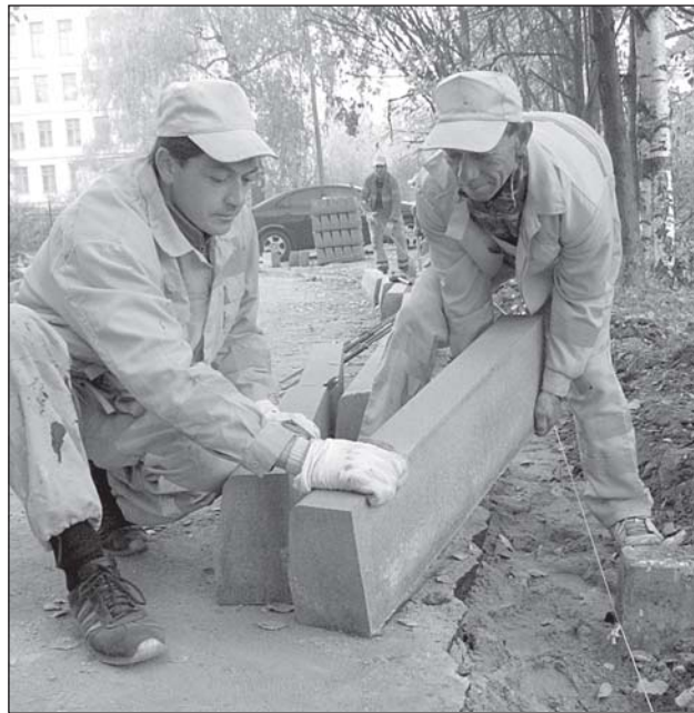
• Дорожные рабочие Артур Ярулин и Геннадий Ильин на укладке бордюров.
