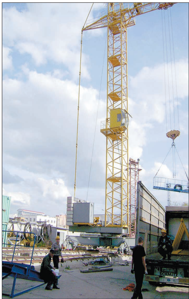
• Испытательные работы нового башенного крана — процедура обязательная: проверяют и устойчивость, и точность полёта стрелы...
