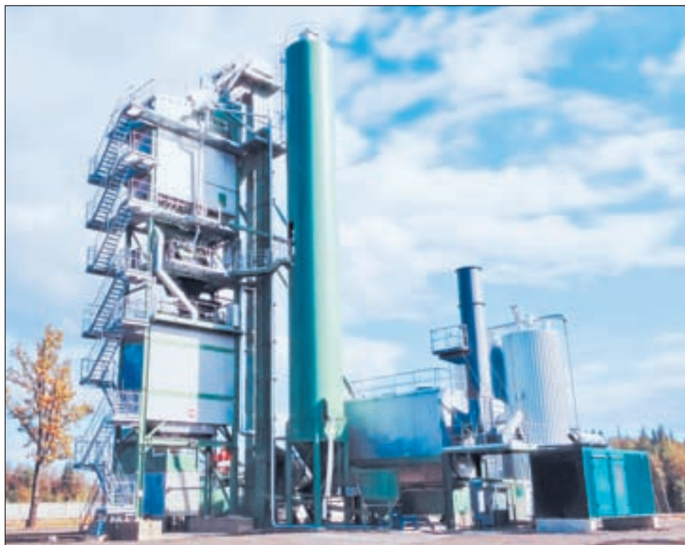
• Строящийся в Часцах асфальтобетонный завод.
