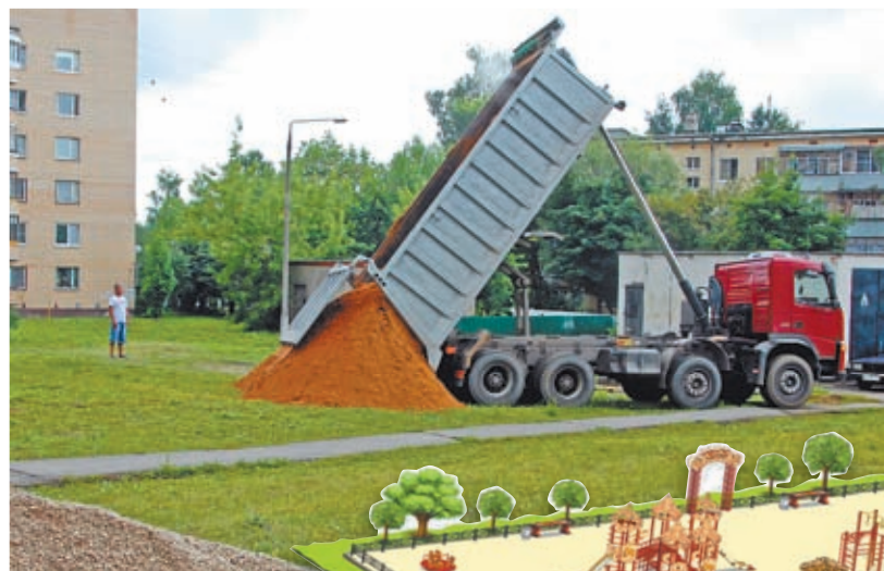
• Строительство площадки «Русич».
