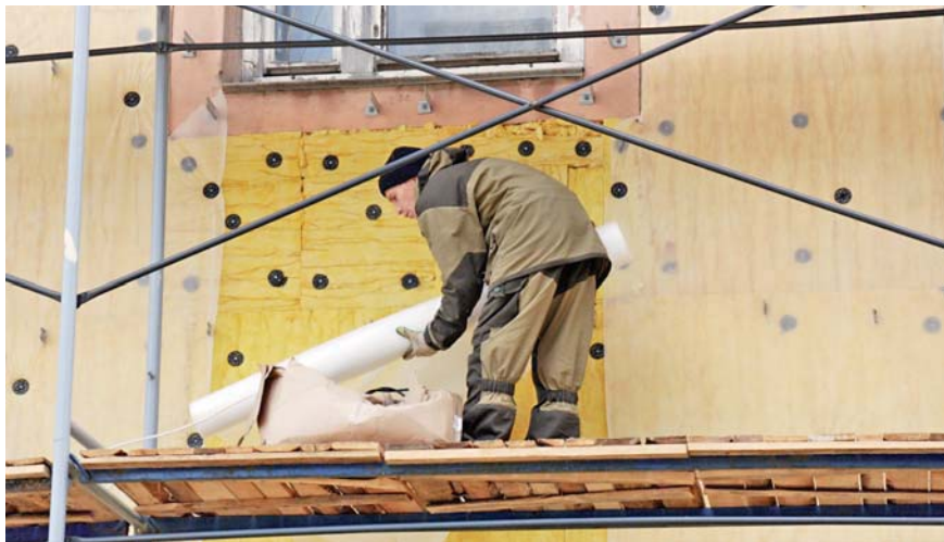
▲ Кровельщик и альпинист Максим Постнов ведет ремонт кровли пятиэтажного дома № 4 по улице Маршала Бирюзова
