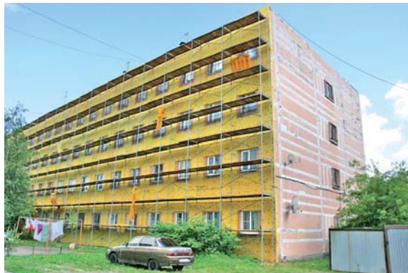
▲ Улица Молодежная, дом 1А. Подрядная организация под контролем АО «УЖХ» ведет утепление фасада. После установки вентилируемого фасада из плитки эти дома, доставшиеся городу «в наследство» от воинской части, будут не узнавать.
