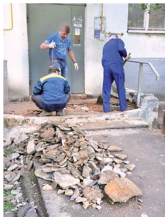
▲ Идет ремонт входных групп старых одинцовских пятиэтажек по улице Садовая.
